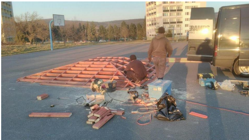
Výstavba novej prekážky v rámci projektu Zažiar v Žiari
