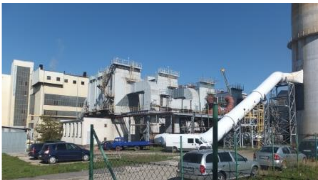
Pohľad na energetický zdroj VU ZH
